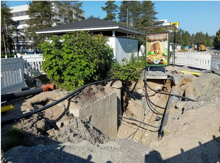
Kuva 1. Putkikaivanto. Bussipysäkki on purettu. Öljysäiliöt sijaitsevat jätekatoksen alla.
